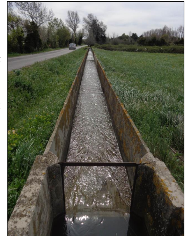
Canal d'irrigation en limite Est du projet Source : TPF Ingénierie
