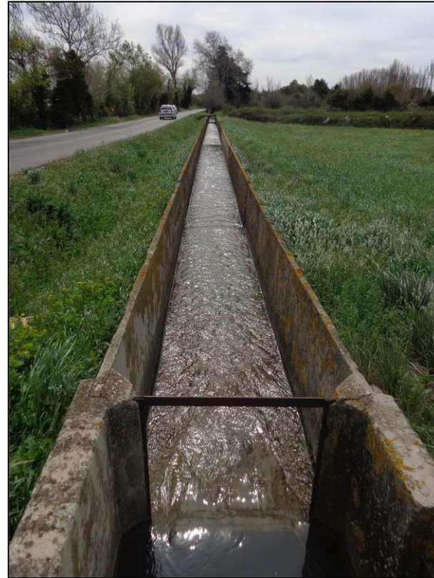
Canal d'irrigation en limite Est du projet Source : TPF Ingénierie
